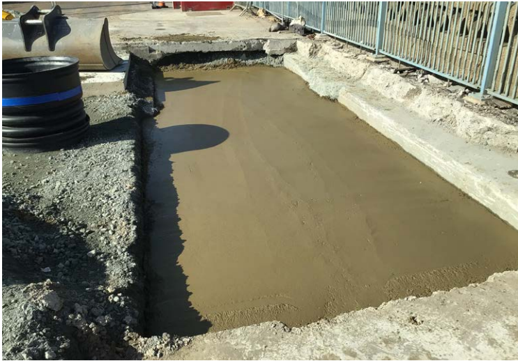
Concrete pour on the South Pier.
